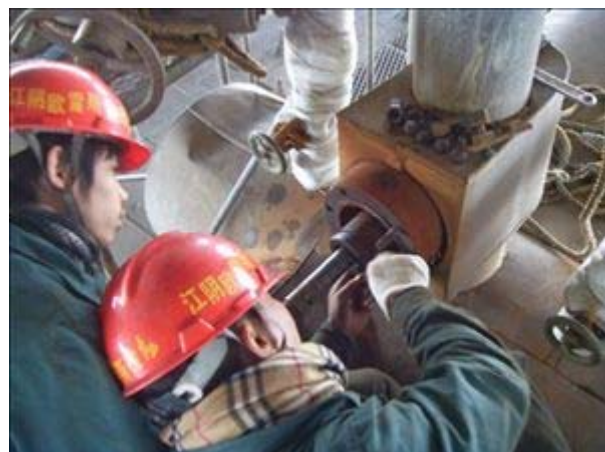
电厂阀门在线维修
