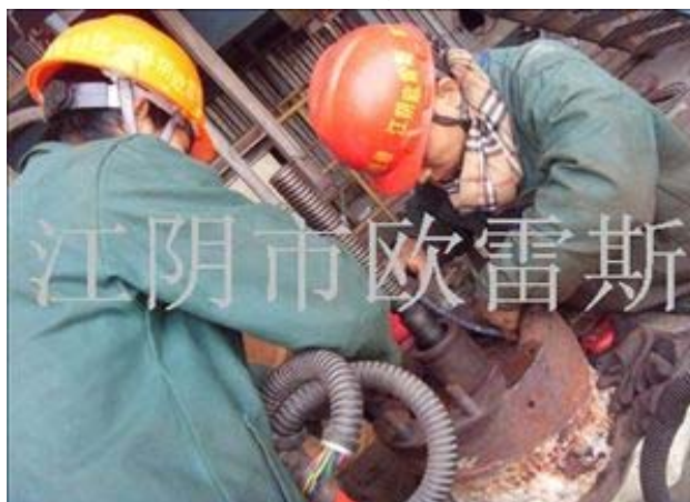
电厂阀门现场维修
