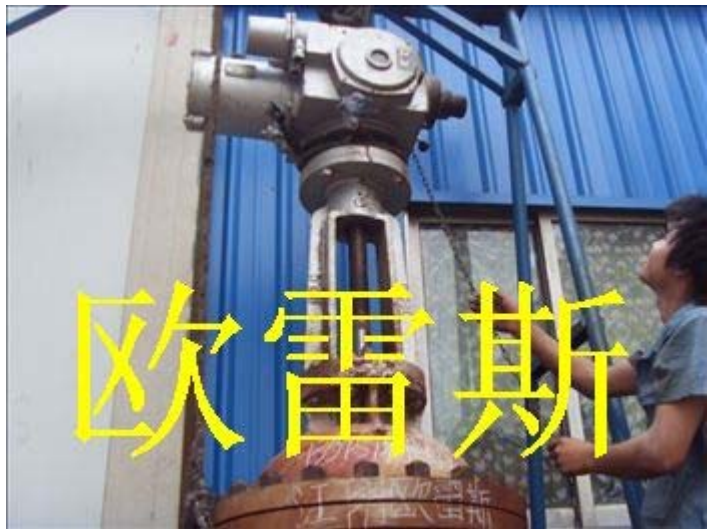
阀门执行连接器维修
